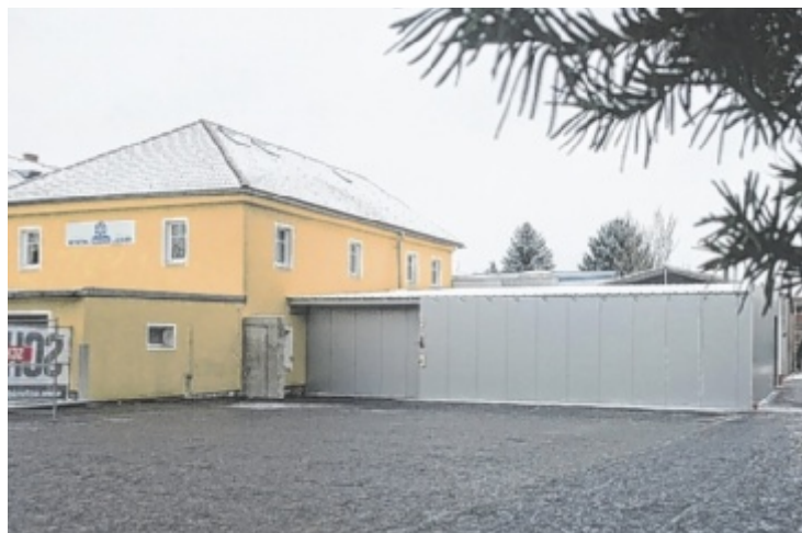
Das Nebengebäude vor dem Umbau
